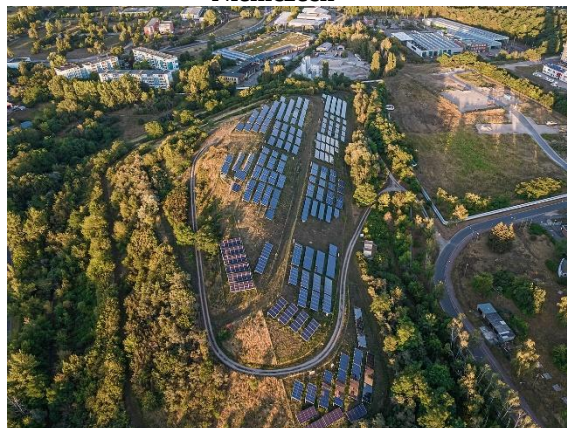
Rysunek 4 Instalacje fotowoltaiczne na dawnym składowisku odpadów we Frankfurcie nad Odrą w Niemczech
